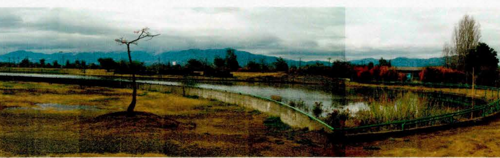
FOTOGRAFÍA HACIA EL NORTE DESDE CAMINO HELICOIDAL (Fuente CMT)
